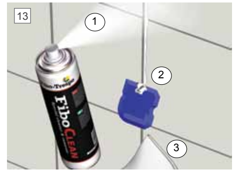
13 Der skal påføres så meget fugemasse at samlingen er tæt. Der skal komme fugemasse ud ved samlingen. Fjernelse af fugemasse sker på følgende måde:
